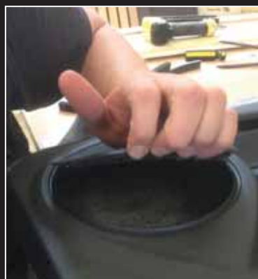
◀ Kuperäinen kaiutinritilä poistettiin ovipahvista ja uusi keskiäänikaiutin tuotiin aivan ovipahvin tasalle. Tällä toimenpiteellä oli suuri vaikutus äänenlaatuun.
